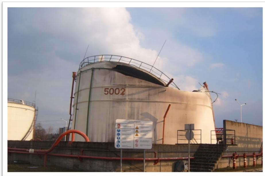
Felrobbant benzintároló tartály ( munkavédelmi hatóság felvétele )
