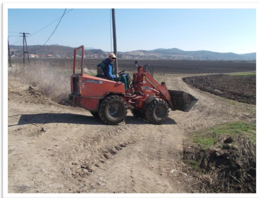
Szabálytalan, védőkeret nélküli rakodógép.
