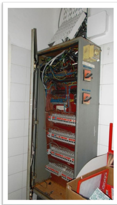
Helytelen gyakorlat - nyitott ajtajú villamos kapcsolószekrény a munkahelyen
