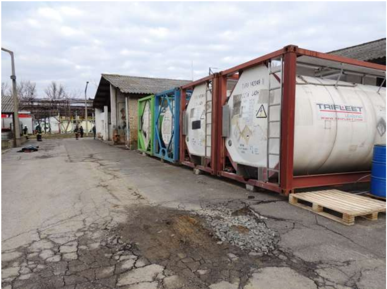
A betonozott tartálpark (munkavédelmi hatóság felvétele)
